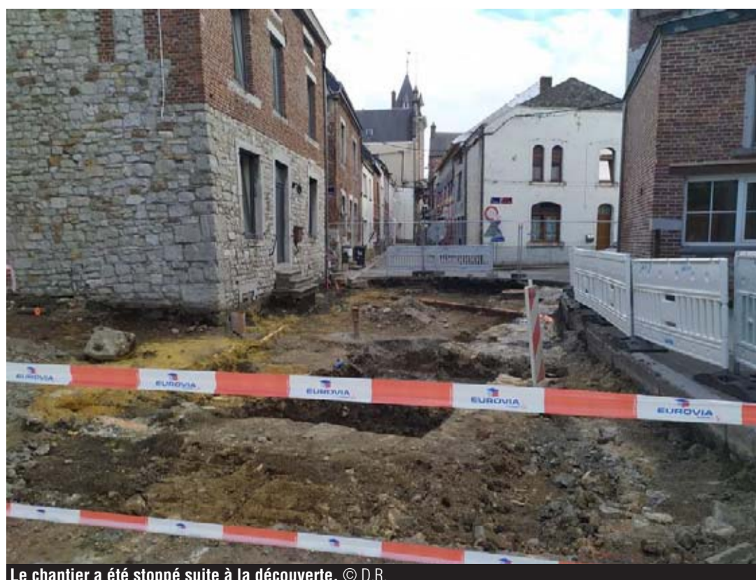
Le chantier a été stoppé suite à la découverte. © D.R.
